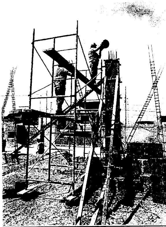
LEVANTAMIENTO DE LA TOTALIDAD DE COLUMNAS DE SALA DE TAREAS PREVIAS
